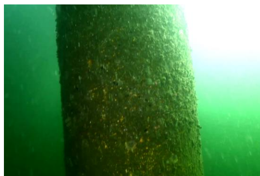
Pieu non équipé
